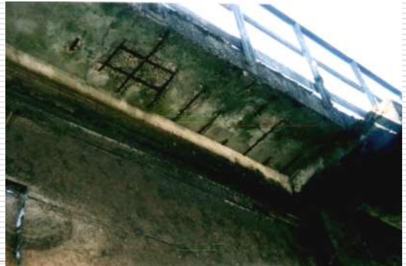
Техническое состояние плит- мостиков
