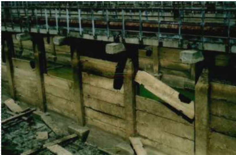
Техническое состояние внутренних стен
