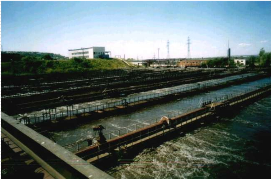
Общий вид аэротенков в рабочем состоянии
