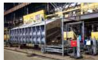
замена КНД на энергоблоке
