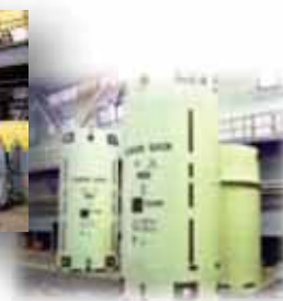
комплекс контейнерного хранения ОЯТ РБМК
