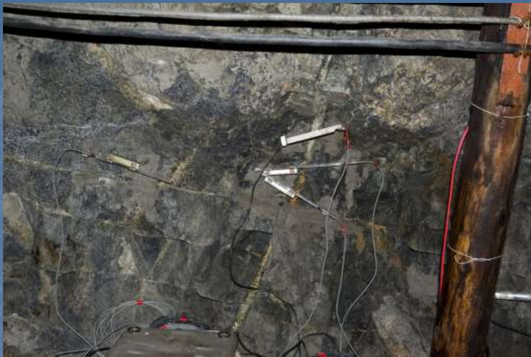
Вид измерительной точки, расположенной на трещине в стенке штольни сейсмостанции «Талая».
