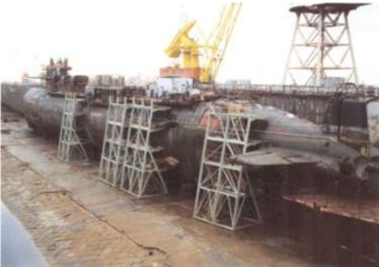
Постановка АПЛ в док-камеру
