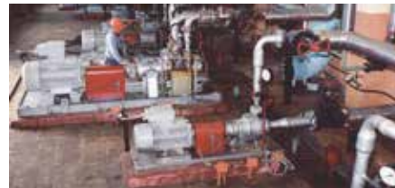
ЦЕНТРОБЕЖНЫЕ Q \leq 1200 \text{ м}^3/\text{ч} P \leq 800 \text{ кВт}
