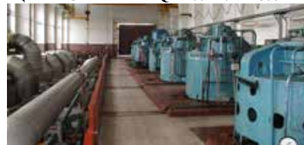
ВЕРТИКАЛЬНЫЕ Q \leq 8000 \text{ м}^3/\text{ч} P \leq 1 \text{ МВт}
