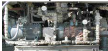
ВИНТОВЫЕ Q \leq 1000 \text{ м}^3/\text{ч} P \leq 60 \text{ кВт}
