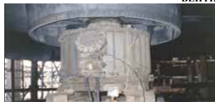
ОХЛАЖДЕНИЯ Q \leq 400\,000 \text{ м}^3/\text{ч} P \leq 90 \text{ кВт}
