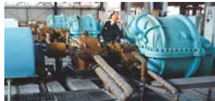
ЦЕНТРОБЕЖНЫЕ Q \leq 200\,000 \text{ м}^3/\text{ч} P \leq 6 \text{ МВт}
